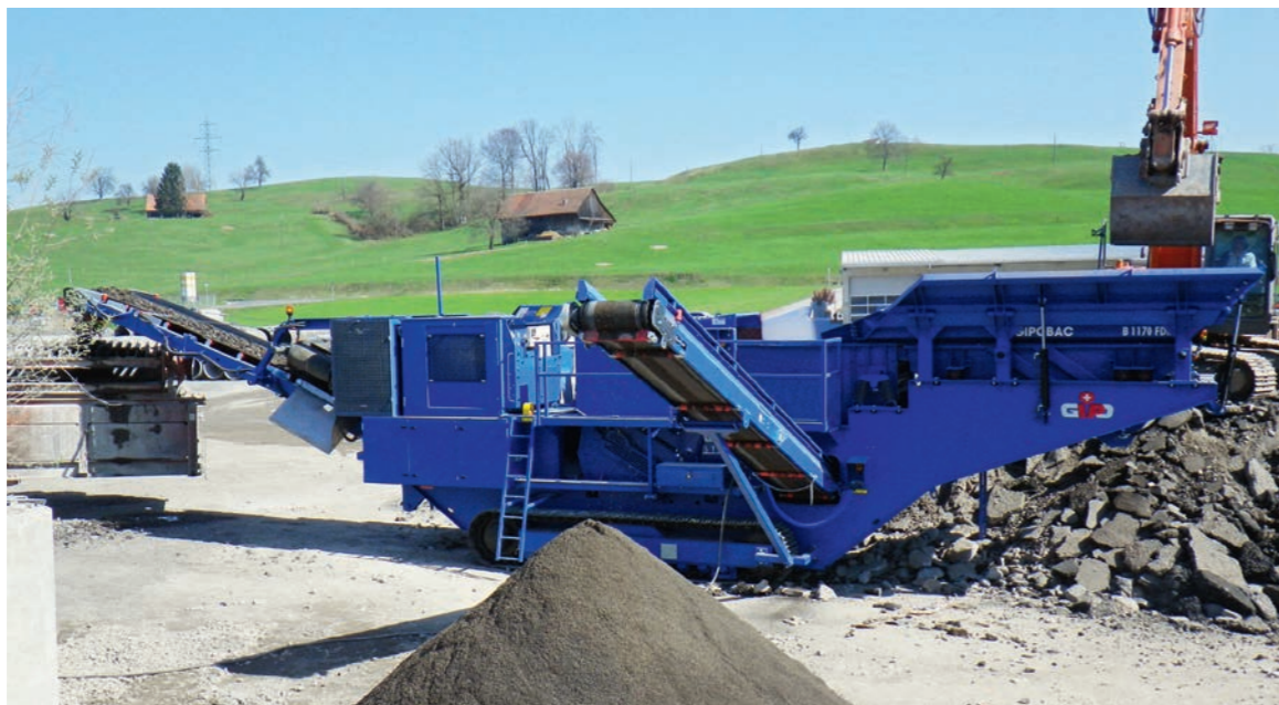
B 1170 FDR Einsatz im Belagsabbruch
