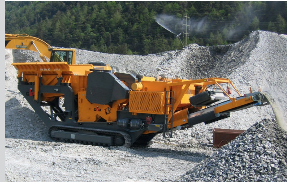
B 1170 C Einsatz im Felsmaterial
