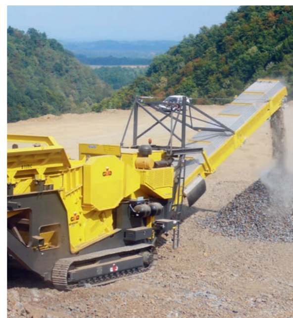
B 1170 C Einsatz im Felsmaterial
